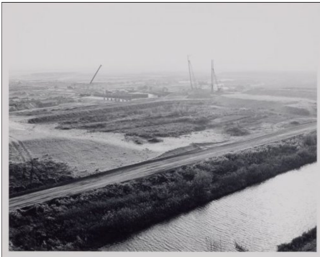
5 De bouw van het oostelijk deel van Holendrecht, gefotografeerd vanuit de flat Hakfort (foto SAA)
