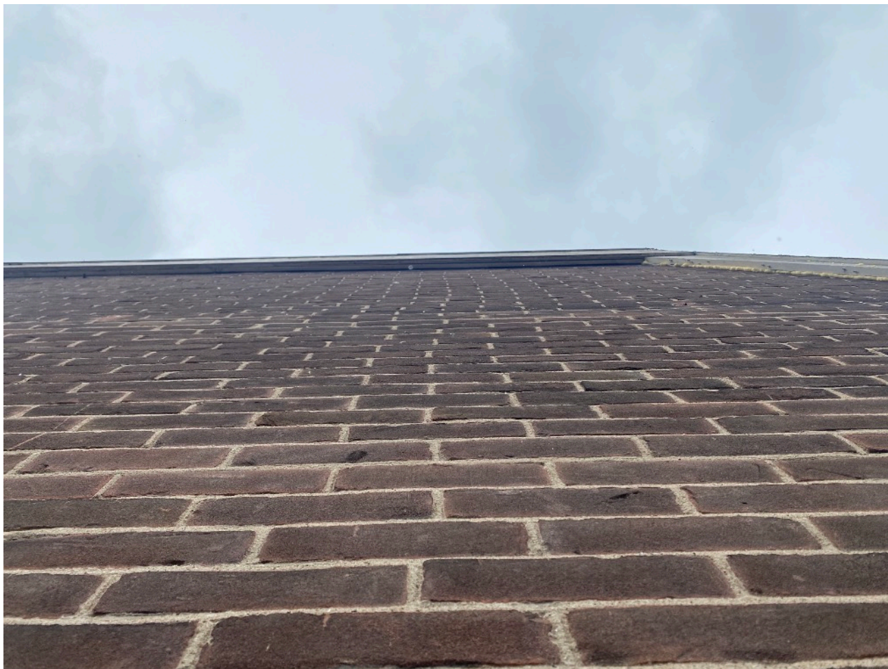
Afb. 4: Voorbeeld van ruimte tussen boeiboord en gevel dat toegankelijk is voor vleermuizen.
