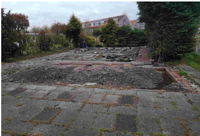
Foto 5: voormalig kantoor en assemblageruimte (vanaf westzijde)
