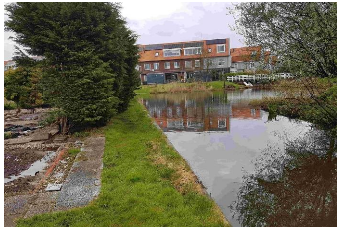
Foto 6: demping/aanvulling langs sloot achterzijde (vanaf westzijde)
