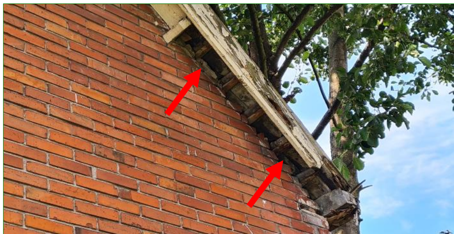
De openingen onder de daklijsten aan de kopse kant van het woonhuis (rode pijlen) geven mogelijk toegang tot voor vleermuizen geschikte achterliggende ruimtes.
