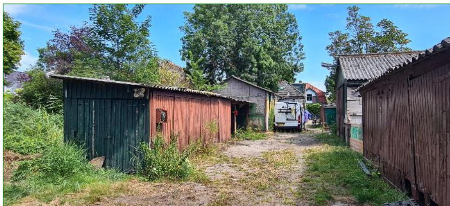
Overzicht van een gedeelte van de aanwezige schuren binnen het plangebied. Op de achtergrond is het dak van het woonhuis zichtbaar.
