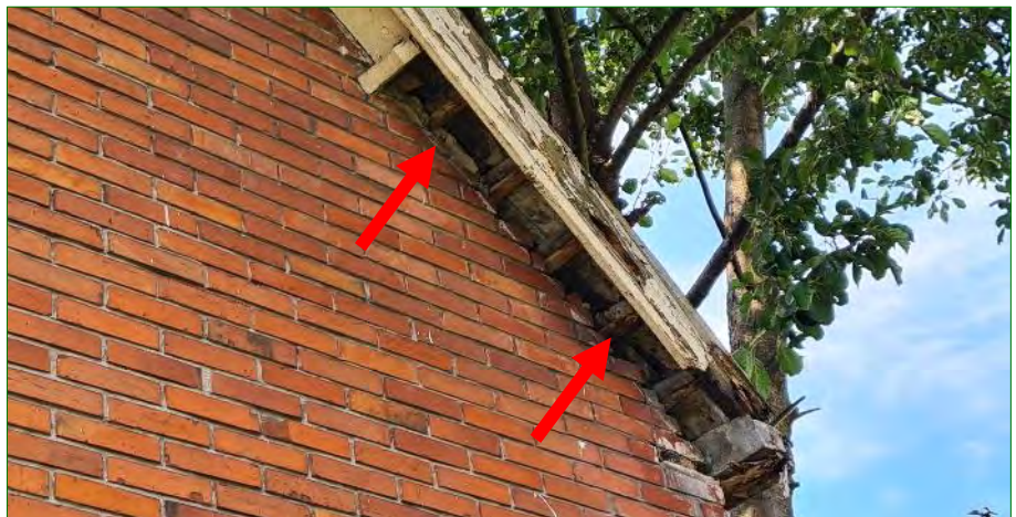
De openingen onder de daklijsten aan de kopse kant van het woonhuis (rode pijlen) geven mogelijk toegang tot voor Gierzwaluw geschikte achterliggende ruimtes.
