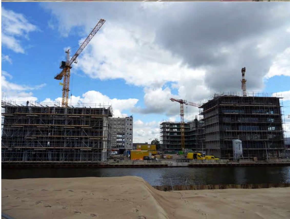
Nieuwbouw Papaverweg en Distelweg
