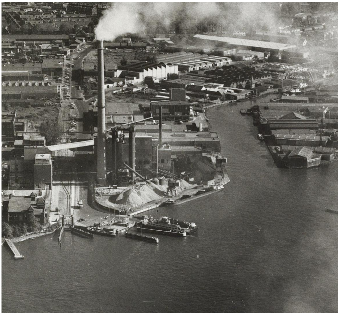
Uitsnede van een foto uit 1972. Op de kop van de Distelweg is links de poort en pontfuik voor de spoorpont en rechts de fuik van de Distelwegveer te zien. Het gebied wordt gedomineerd door de 'Electro' Zuur- en Waterstoffenfabriek (later AGA), waarbij vermoedelijk ook de schoorsteen en de kranen op de kades horen (SAA, Booooooo34205).
