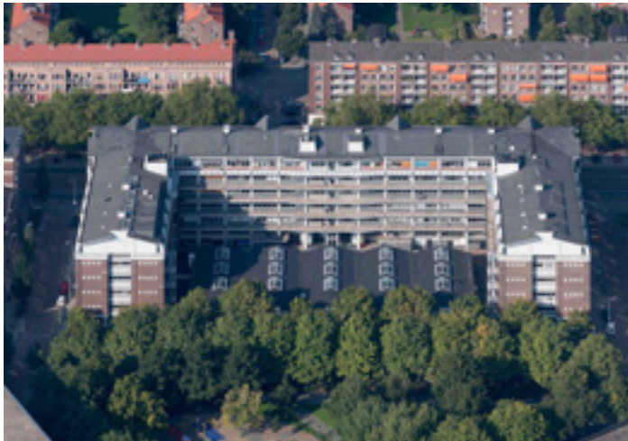
Afbeelding 2.4.7 :Werkrumtes beslaan volledige begane grond; Industriegebouw, Rotterdam
