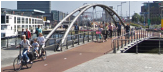
Afbeelding 3.7.2: Brug 2274 in bestaande locatie aan de De Ruijterkade
