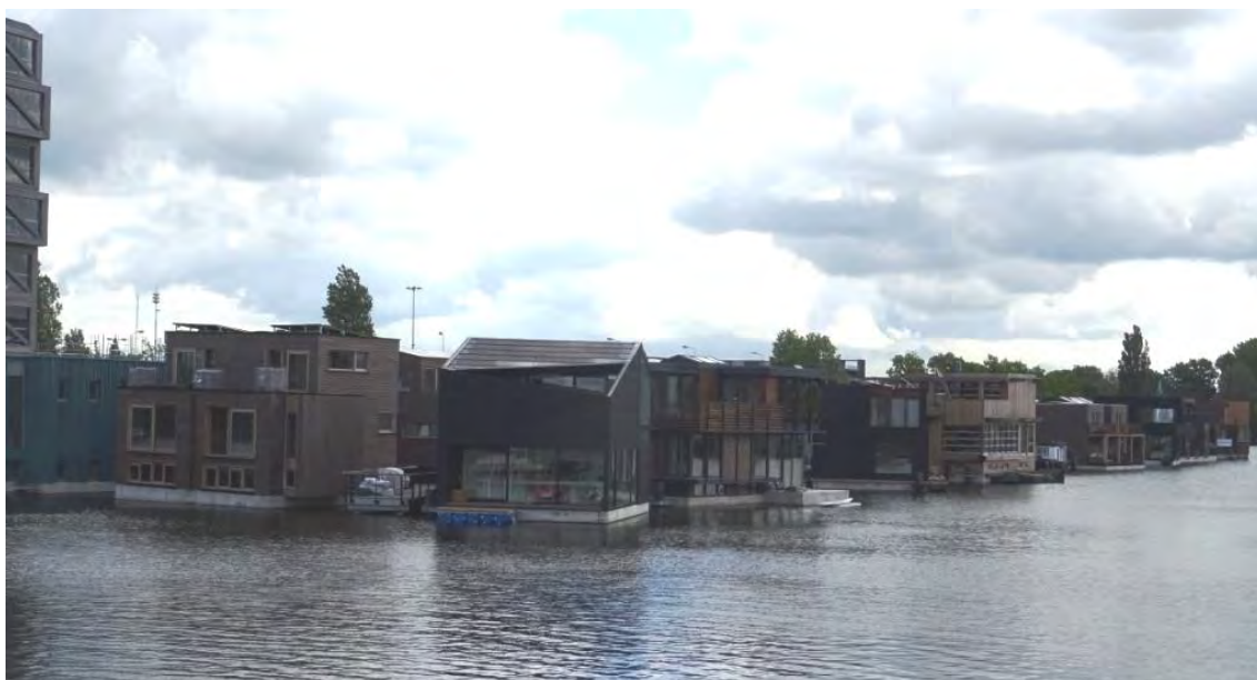
Nieuwe bebouwing in en op het Johan van Hasseltkanaal.
