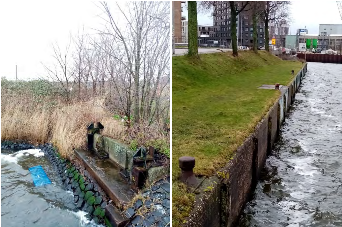
Links: Relict spoorpont ter hoogte van de Distelweg (MenA, 2022).
