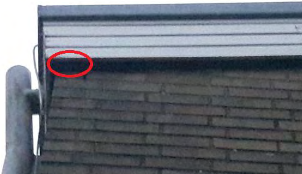
Afbeelding 3: foto van de verblijfplaats onder de daklijst aan de oostzijde.
