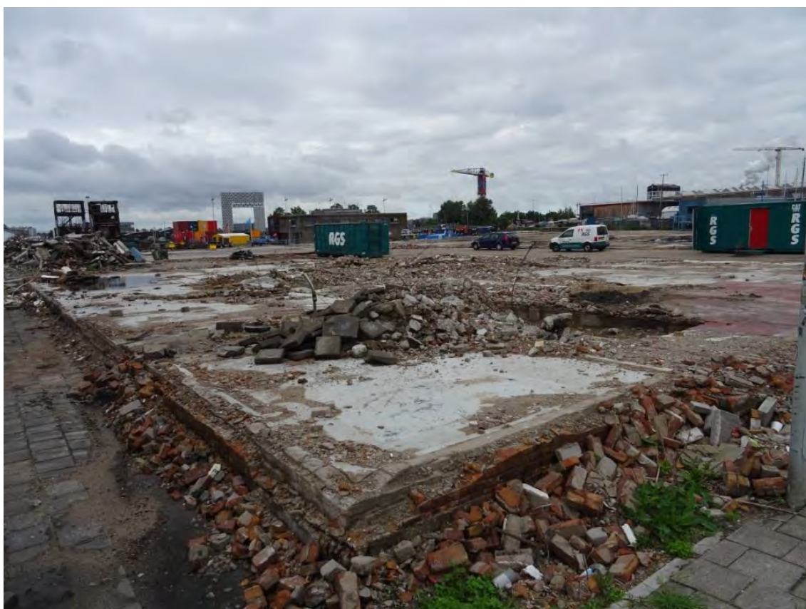
Recent gesloopte oude industrie langs de Klaprozenweg ten behoeve van woningbouw
