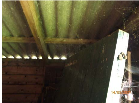
Afbeelding 12. De binnenzijde van de te slopen schuur
