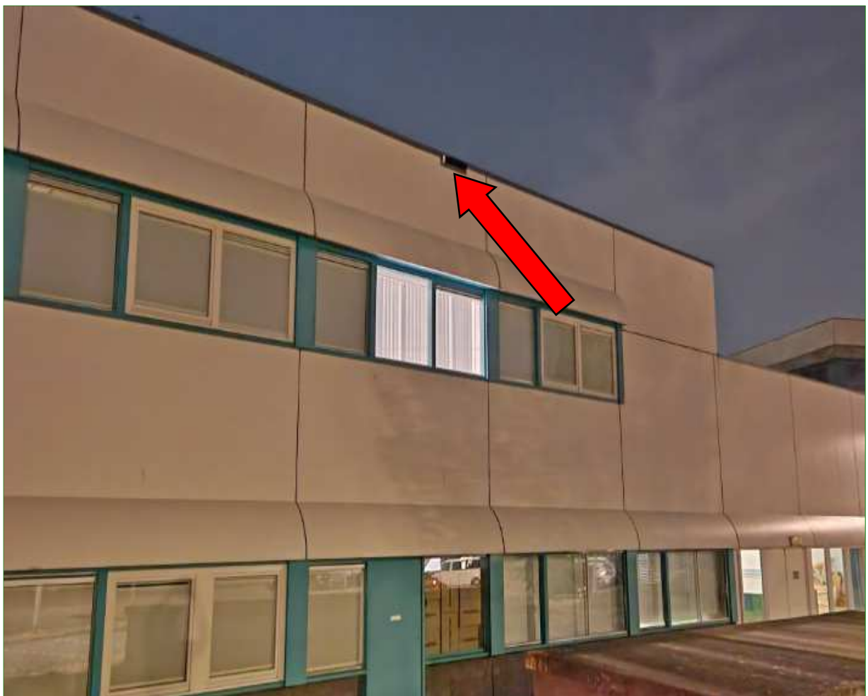
De locatie (rode pijl) aan noordwestkant van de bebouwing waar een verblijvende Gewone dwergvleermuis is aangetroffen.
