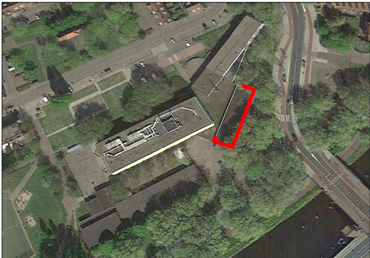
Figuur 5: bakstenen gevels met geschikte open stootvoegen voor vleermuizen (rood gemarkeerd) (bron luchtfoto Google Earth)
