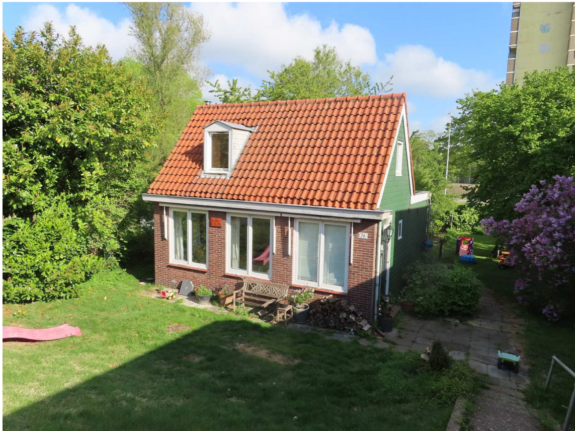
Figuur 2. Huidige situatie van het woonhuis aan de Oostzanerdijk 76 te Amsterdam.
