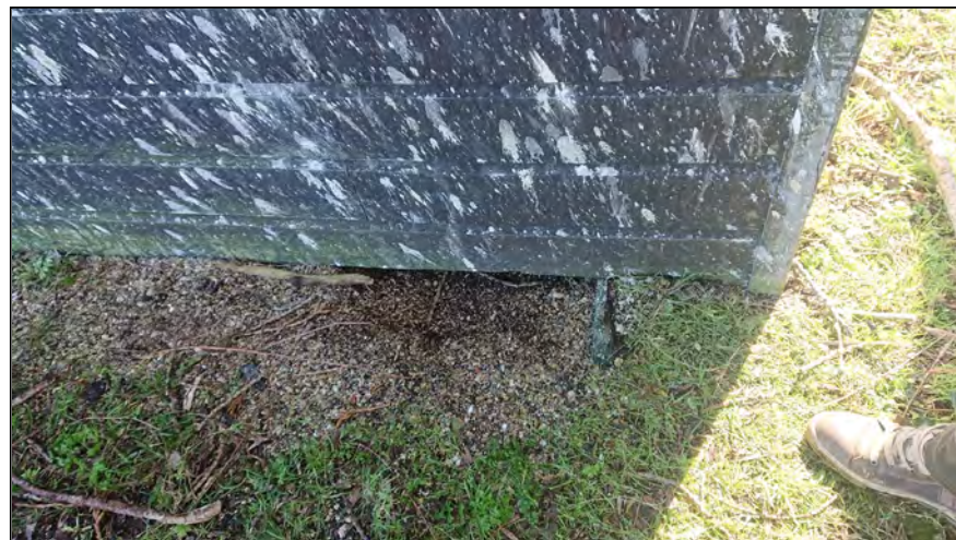
Figuur: in de opening onder de schuur is een (hoofd)verblijfplaats van boommarter vastgesteld.
