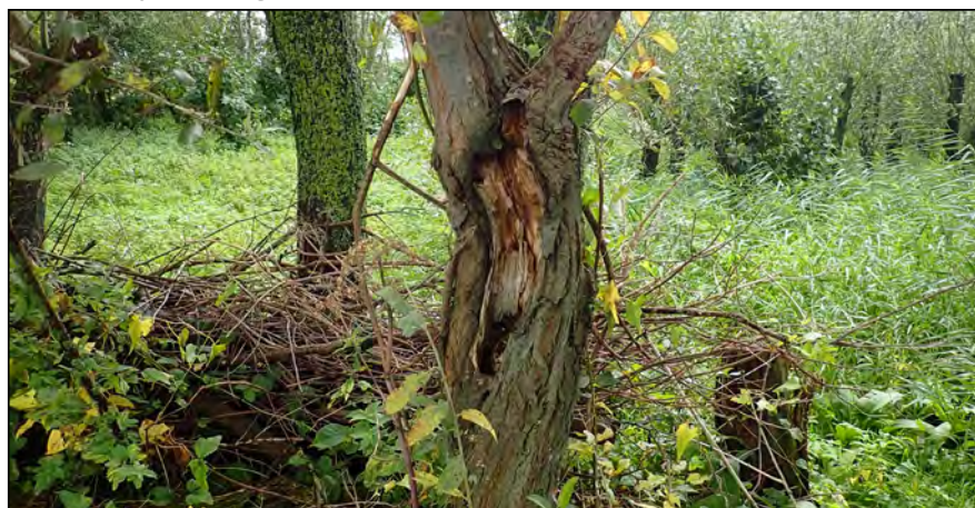
Figuur: de vele bomen in het plangebied bevatten mogelijk holtes waar vleermuizen verblijfplaatsen in kunnen hebben of grote vos winterverblijfplaatsen in kan hebben. Tijdens het veldbezoek konden niet alle bomen geïnspecteerd worden door het aanwezige bladerdek. De holtes op de foto waren niet doorlopend.
