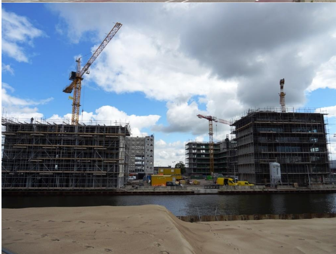
Nieuwbouw Papaverweg en Distelweg
