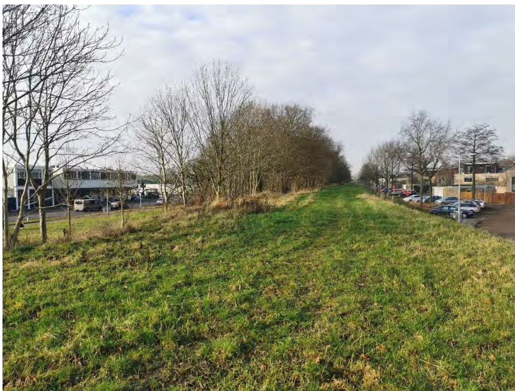
Overzichtsfoto met bomen begroeide dijk aan noordkant projectgebied met links de Metaalbewerkerweg en rechts de Buiksloterbreek
