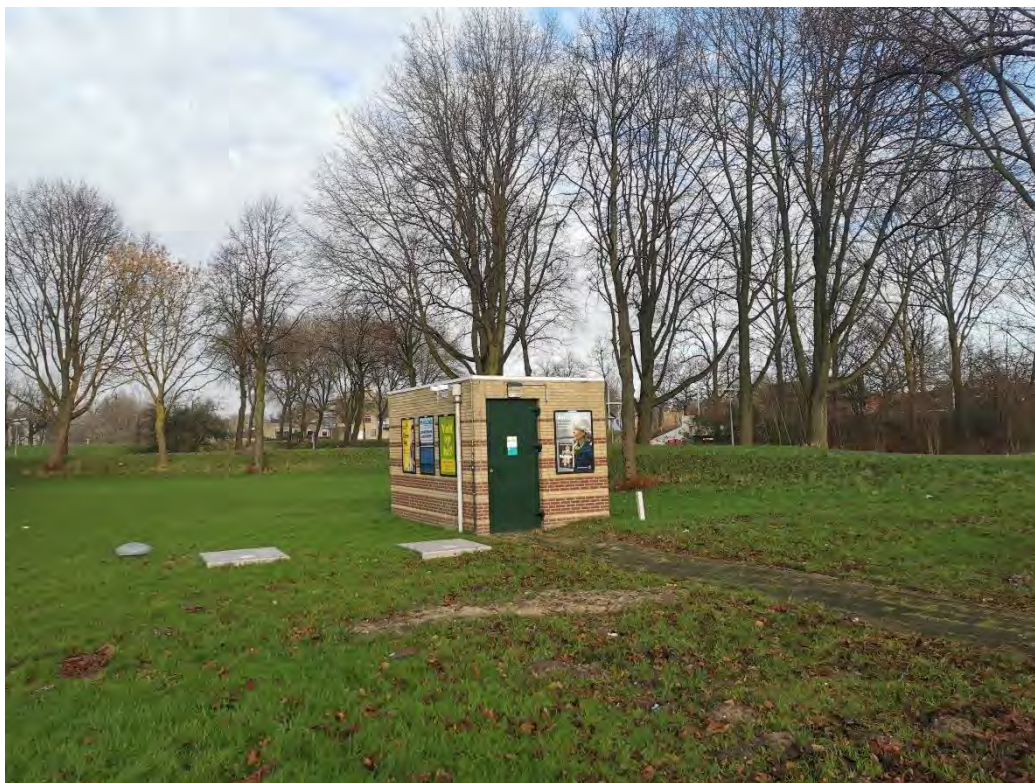
Grasveld en transformatorhuis met op de achtergrond bomen aan oostkant projectgebied
