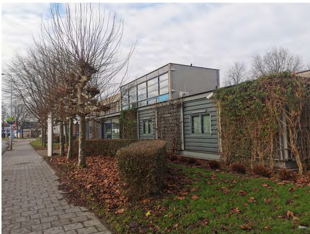
Ymere gebouw langs de Floraweg aan oostkant projectgebied
