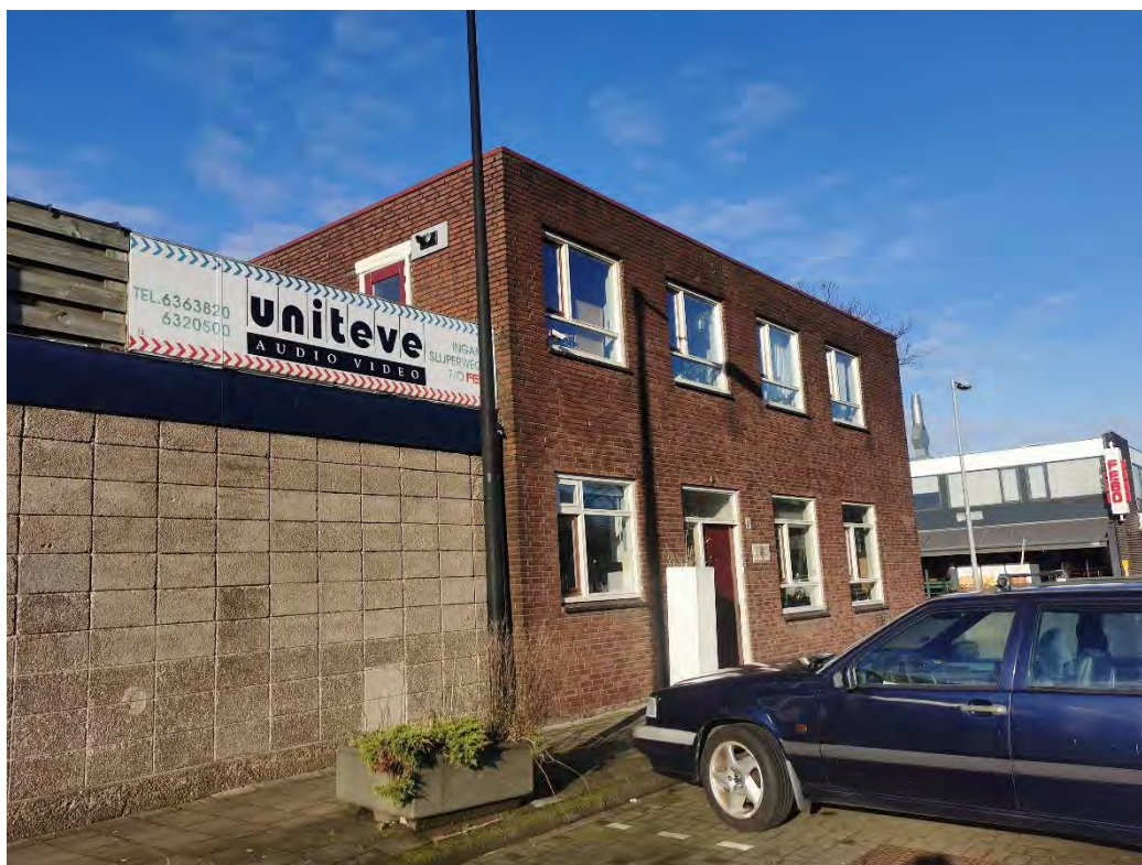
Woonhuis op hoek Vuurwerkerweg
