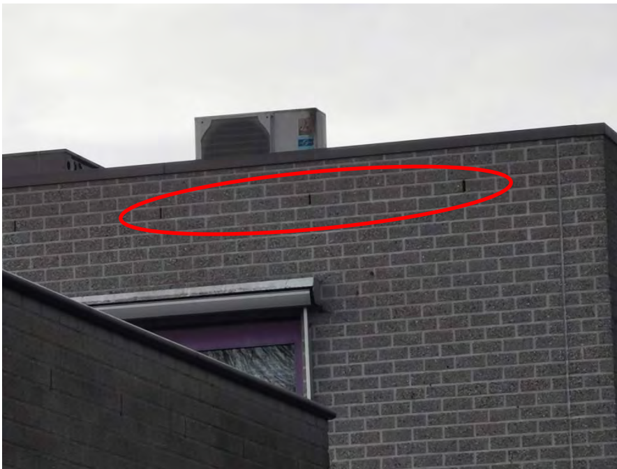
Open stootvoegen Ymere gebouw aan oostkant projectgebied
