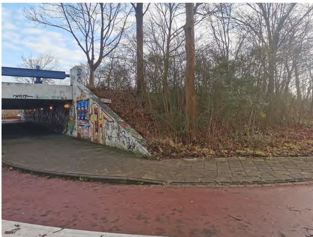
Begroeiing op talud naast viaduct aan oostkant projectgebied
