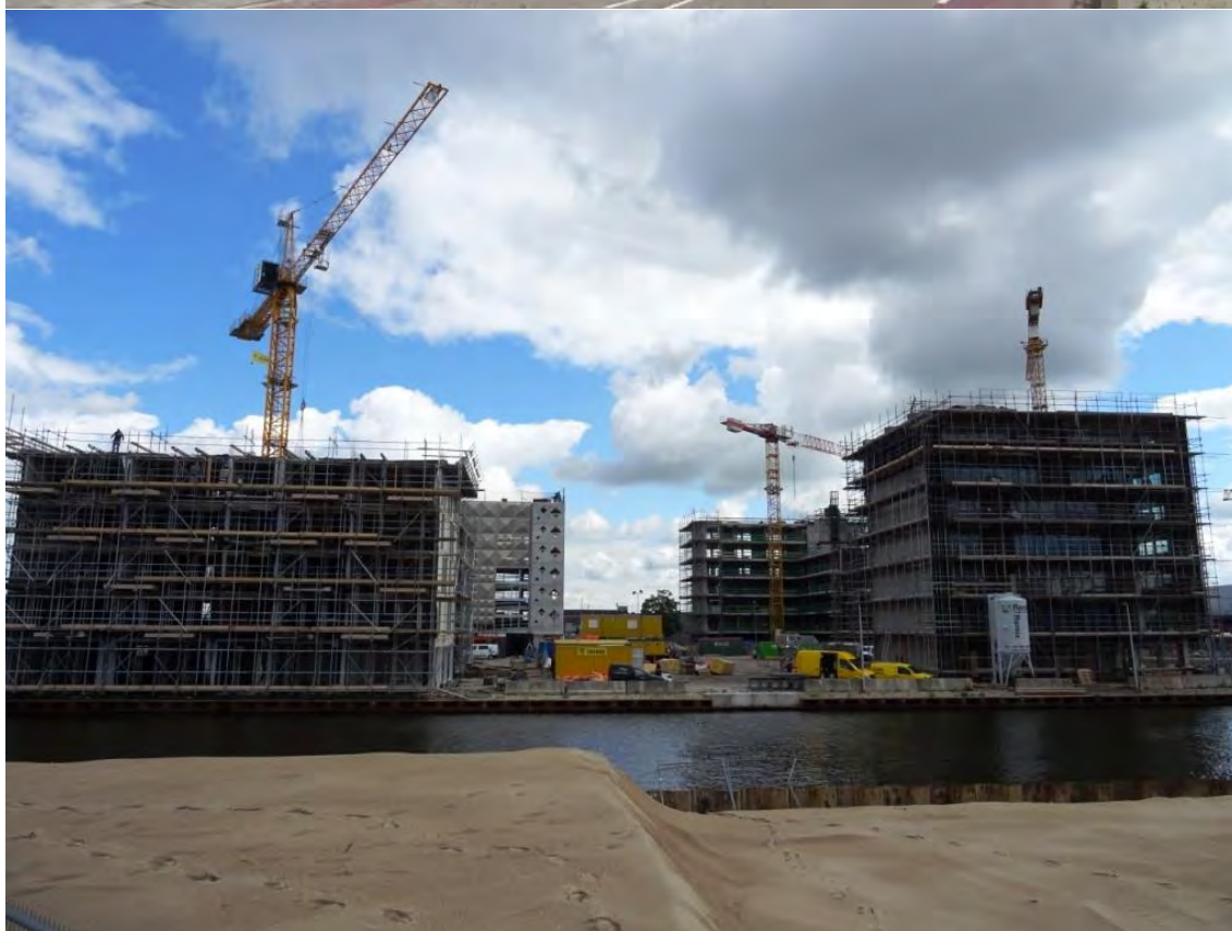
Nieuwbouw Papaverweg en Distelweg
