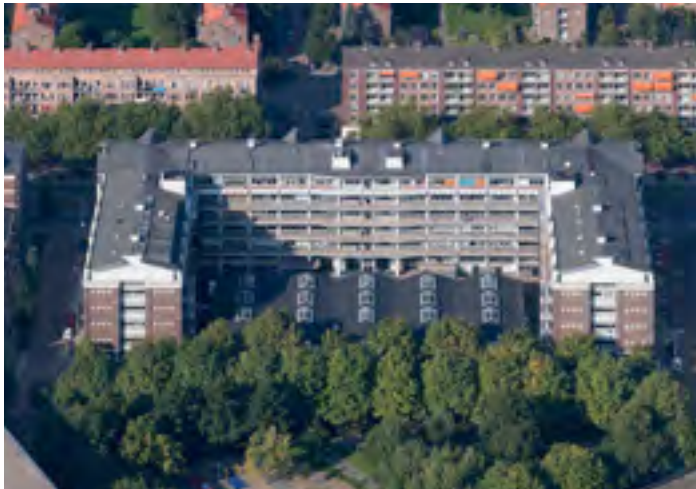
Afbeelding 2.4.7 :Werkrumtes beslaan volledige begane grond; Industriegebouw, Rotterdam
