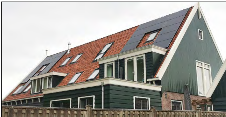
Figuur: de woningen naast het plangebied hebben pannendaken waar huismus onder tot broeden kan komen. Er zijn drie huismussen aangetroffen op het afgebeelde dak. Dit woonhuis staat 4 meter ten westen van het plangebied.
