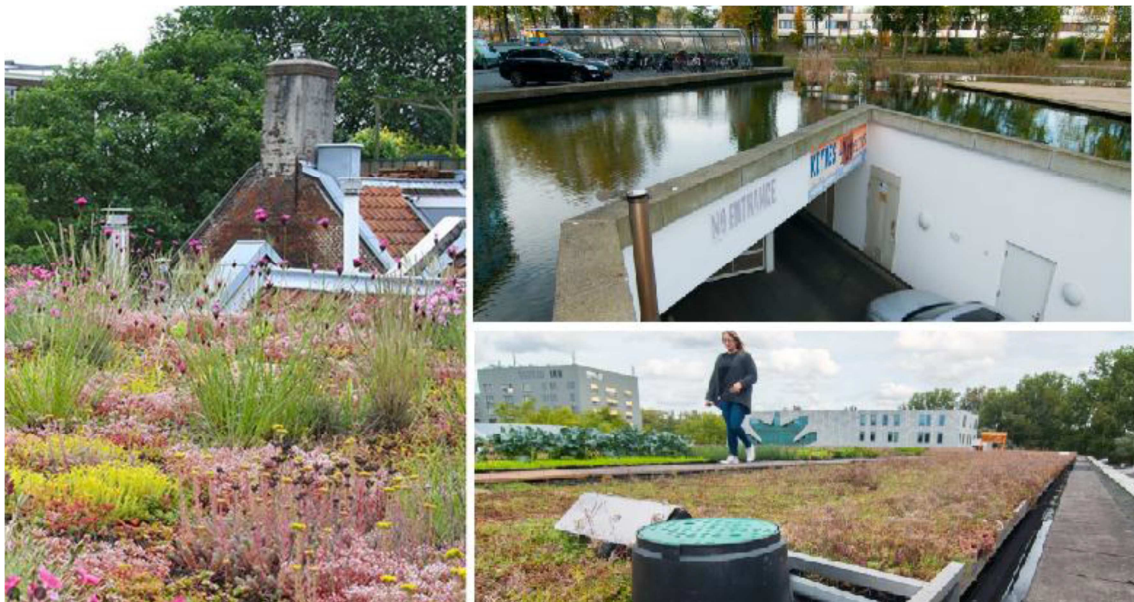
Figuur 7-3 Voorbeelden van groene waterbergende daken
