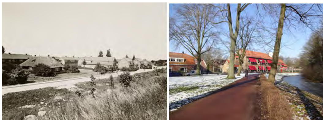
Afbeelding: de Oostzanerdijk (hier ter hoogte van de Centaurusstraat, 1932) biedt uitzicht op het markante dakenlandschap van het tuindorp en rechts de zuidoostelijke rand van het tuindorp, met een schoolgebouw, een groene open ruimte en het fietspad dat door een hegje begeleid wordt
