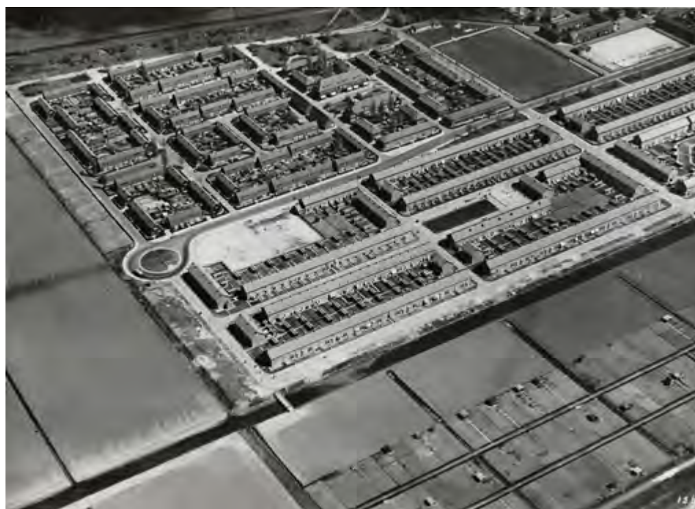
Afbeelding: boven het oudere deel van Tuindorp Oostzaan, met linksboven het Plejadenplein, en onder de lange rijenhuizen, 1938
