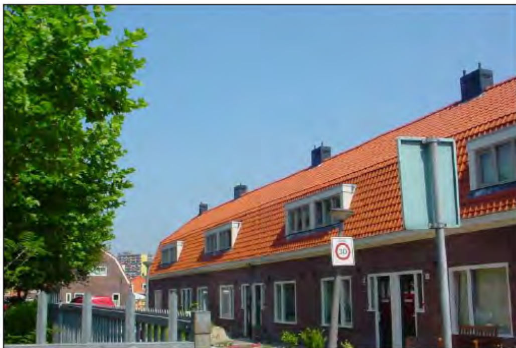
Afbeelding: aaneengesloten dakkapellen aan de voorzijde (kapvorm type A en C)
