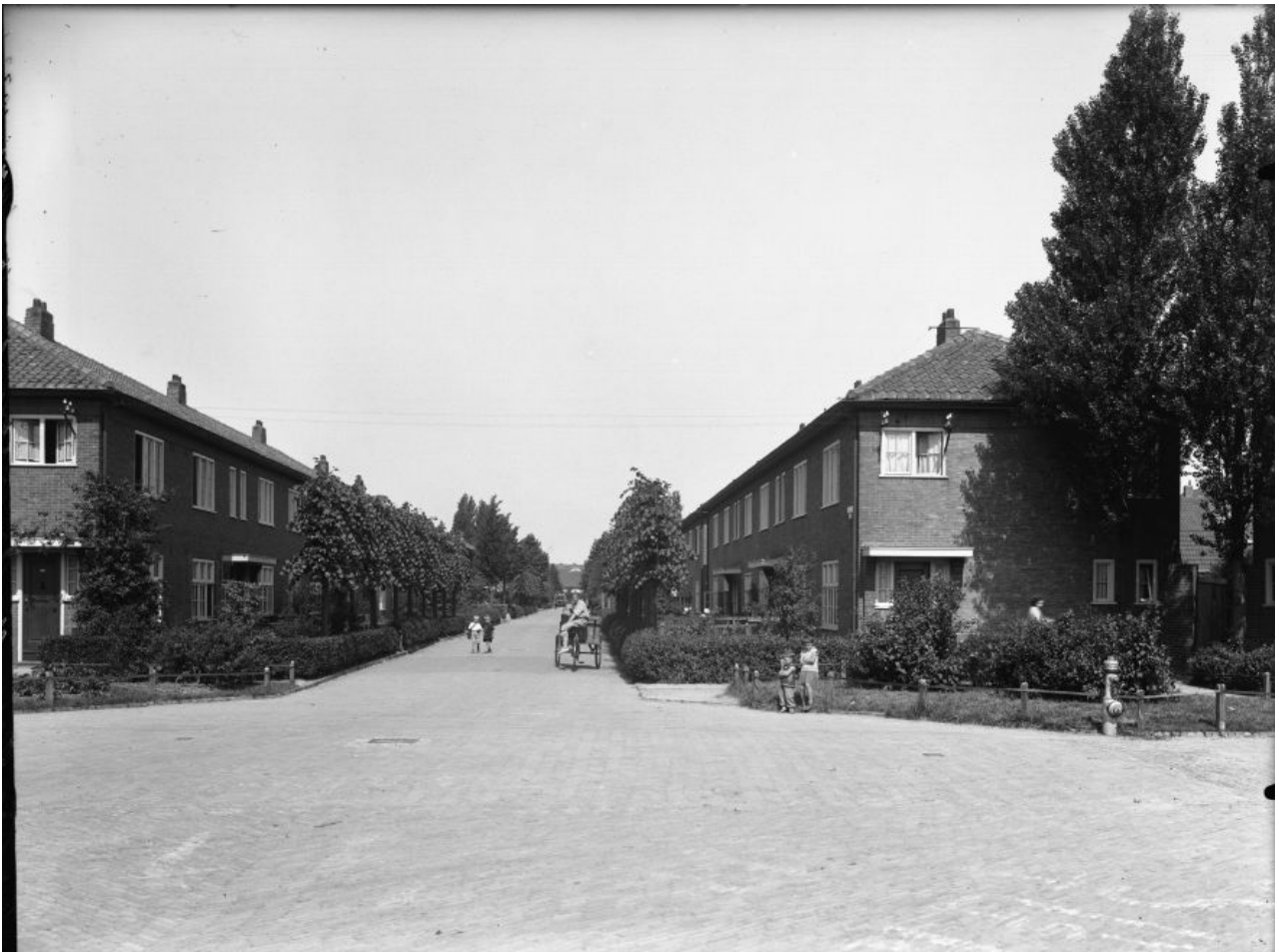
In de voortuinen bomen en heggen als erf afscheiding, en laag hekwerk als afsluiting van de plantsoenen, Orionstraat, 1933 (SAA: 5293FO003242)
