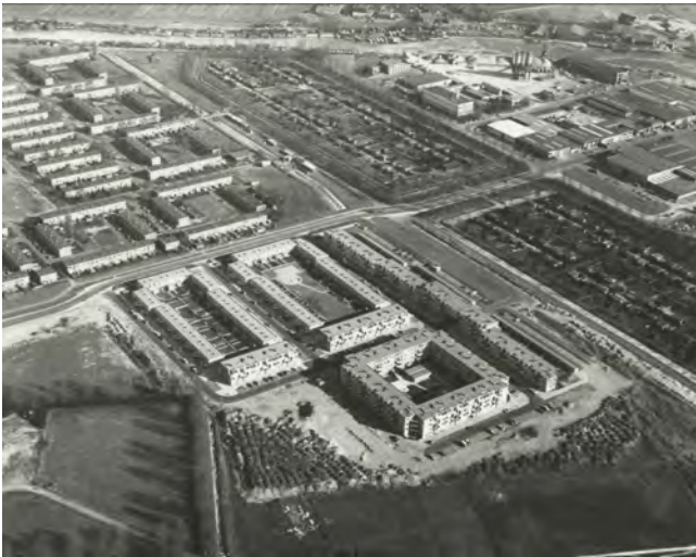
Woonblokken aan de Werktuigstraat, Tegenhouderstraat en Klinkerweg, 1985 (SAA: B00000036691)
