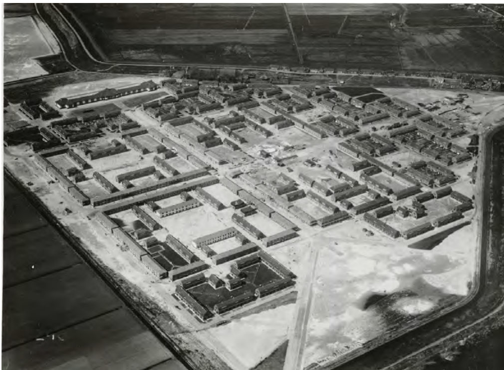
Het eerst gerealiseerde deel van het Tuindorp Oostzaan tussen de Meteoroenweg (links), de Oostzanerdijk (boven) en de Kometensingel (rechts), 1923 (SAA: A04139000060)
