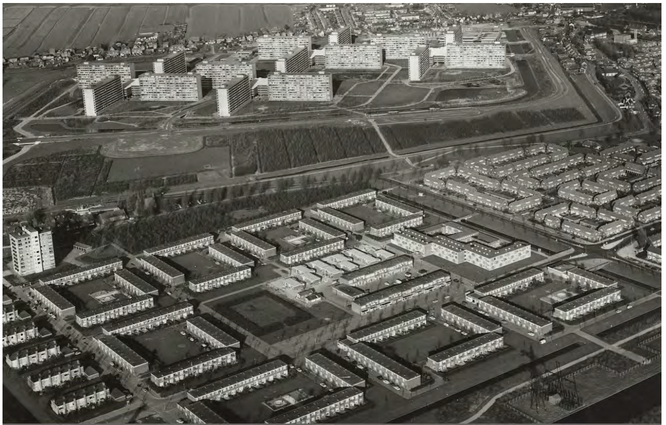
Luchtfoto van de uitbreiding Oostzaan-West, met rechts het vooroorlogse tuindorp en boven Moelnwijk, 1972 (SAA: B00000034007)
