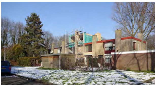
Woningen in twee lagen aan de Schutterweg.
