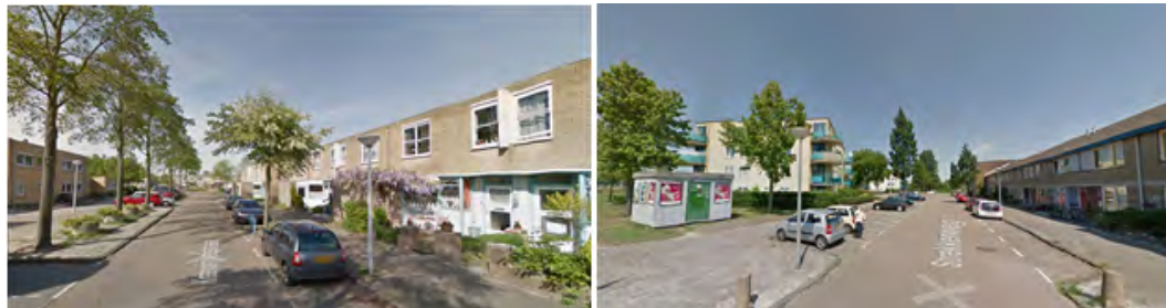
Afbeelding: links rijtjeshuizen met voortuinen en boombeplanting in de Werktuigstraat en rechts laag- en hoogbouw aan de Strekkerweg
