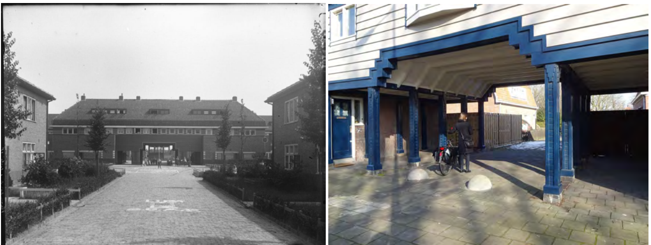
Zonneweg, met zicht op poortgebouw, 1925 (SAA: 5293FO003261, foto B.T. Boeyinga) en anno 2017 toegeëigende openbare ruimte (voormalige stoep) met schuttingen die zichtlijnen blokkeren.
