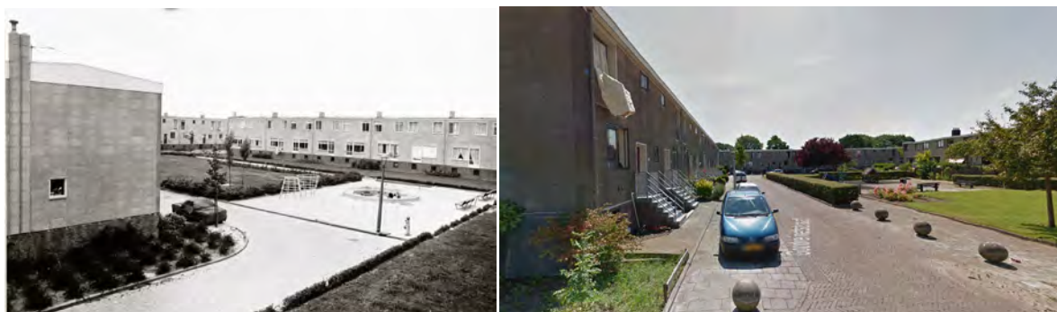
Goudreinetstraat in 1974 en tegenwoordig (SAA: B00000009002 en foto Google Maps)
