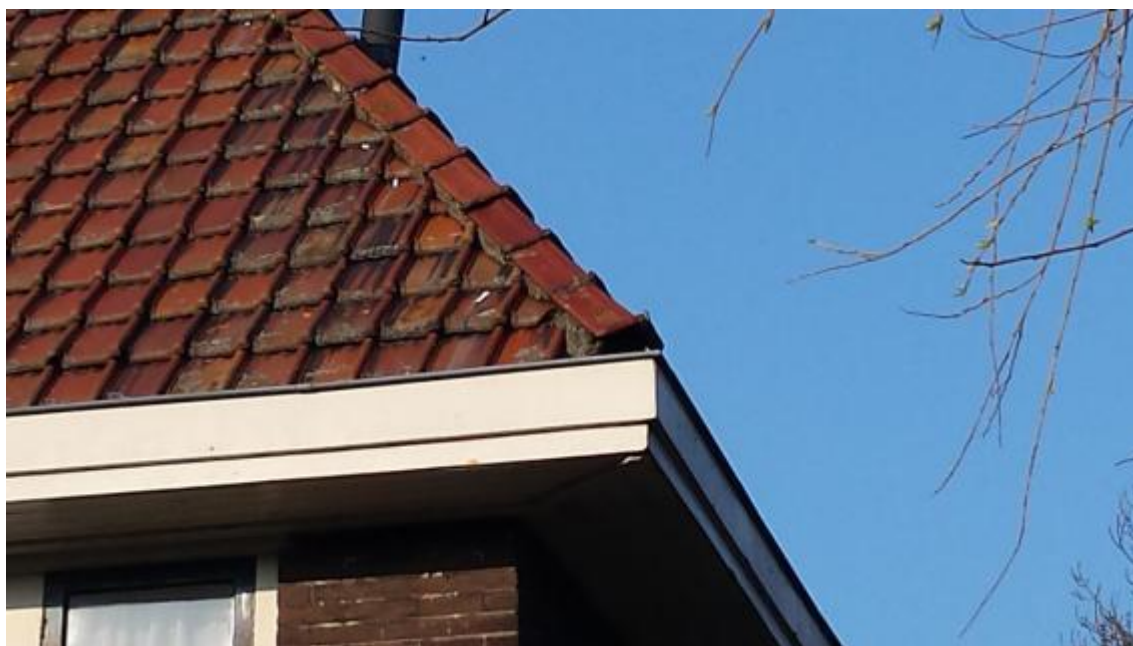
Ruimte onder dakpannen is toegankelijk
