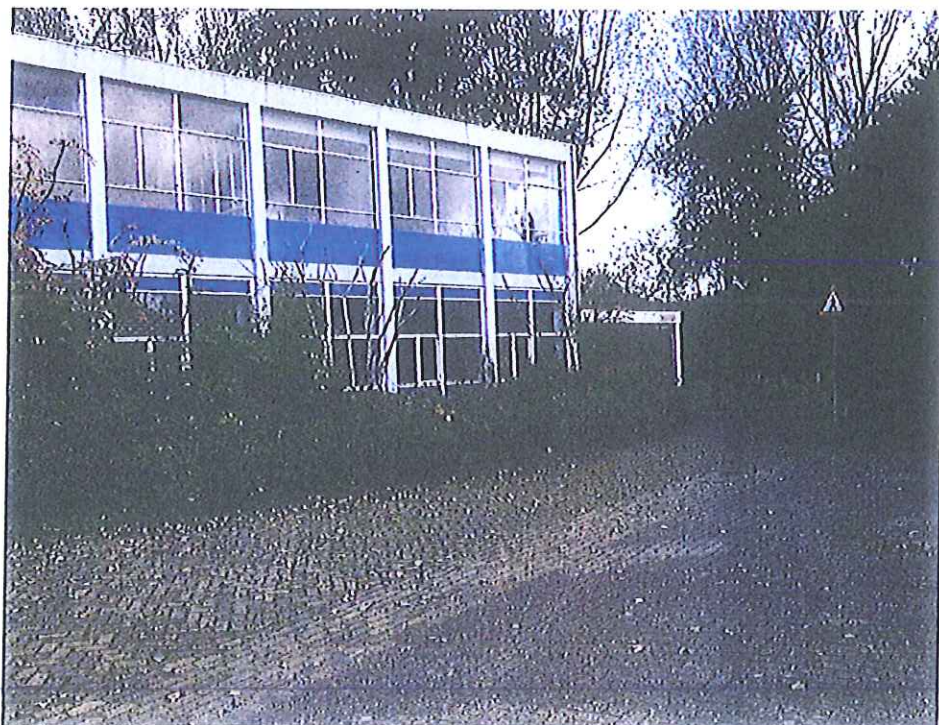
Fig. 4 Gebouw met mogelijke zomerverblijfplaatsen vleermuizen
