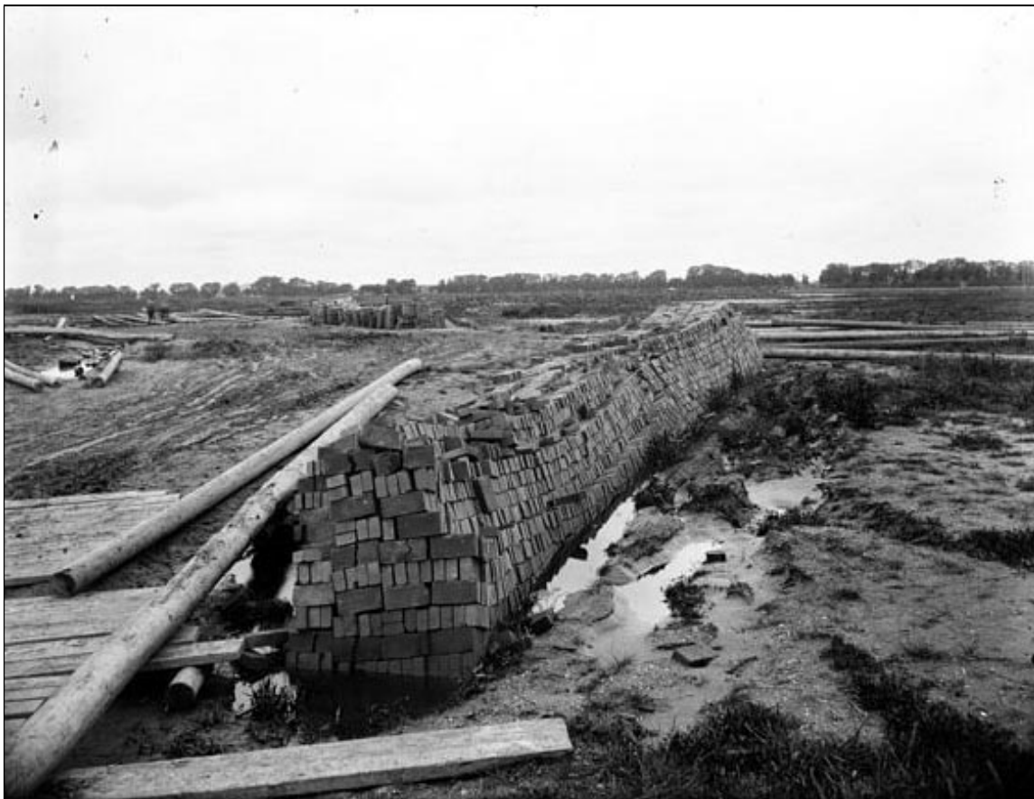
4 Start van woningbouw in de Buiksloterhampolder, september 1923 (foto SAA)
