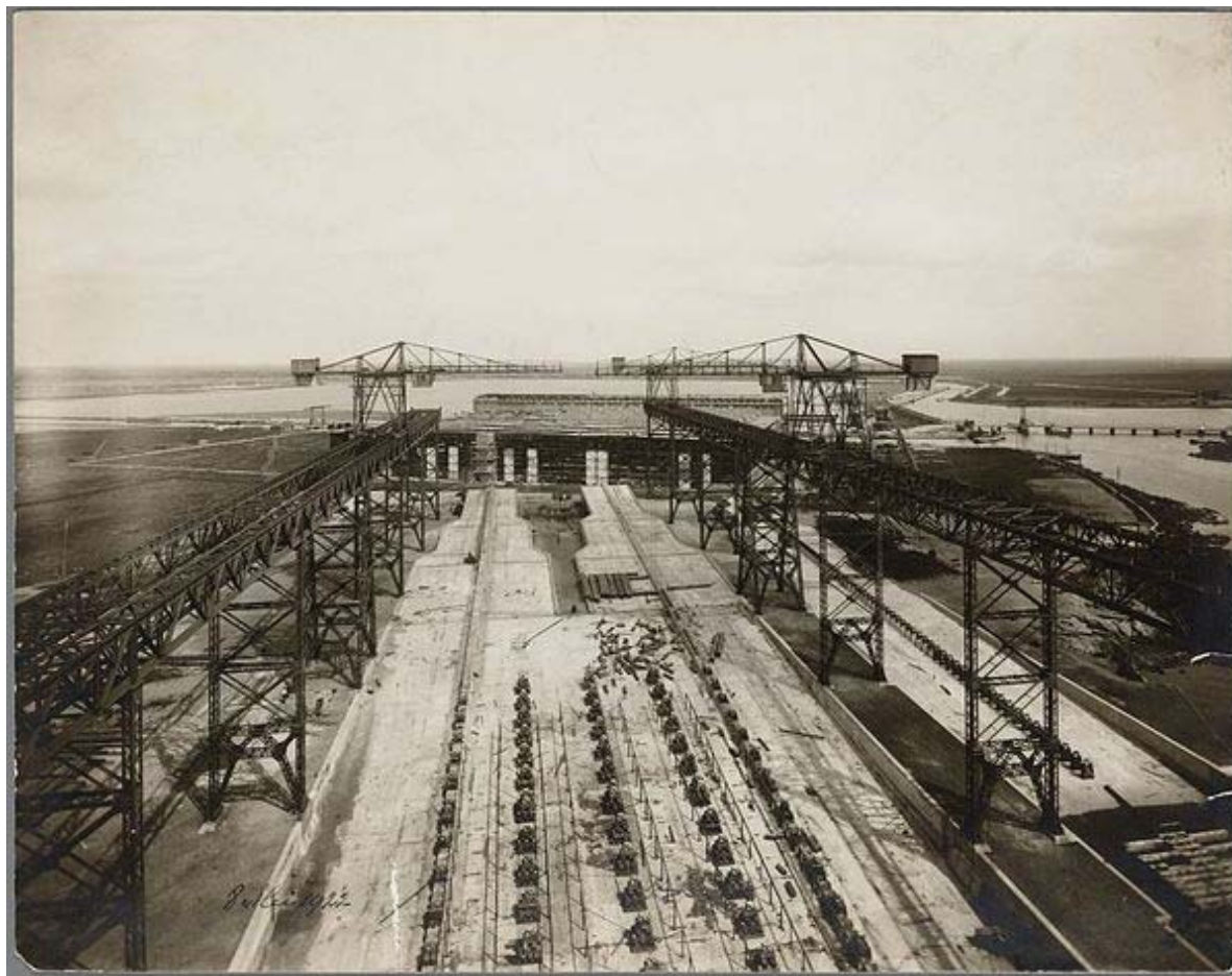
5 Helling op de nieuwe werf van de Nederlandsche Scheepsbouw Maatschappij (N.S.M.) in 1922, enkele maanden voor de opening. Op de achtergrond, na de loods het Cornelis Douweskanaal; rechts Zijkanaal I. (foto Stadsarchief)
