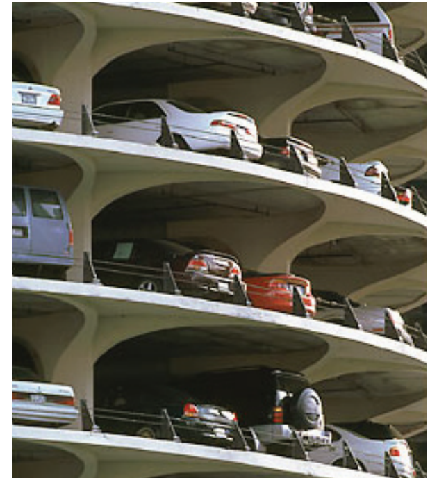
Zichtbaarheid parkeerfunctie in de gevel
