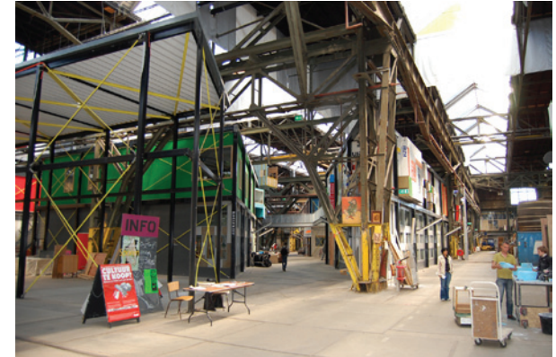
Oorspronkelijke constructie in het zicht
