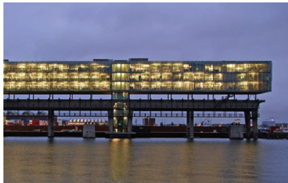
Nieuwe toevoeging los van de historische bebouwing
