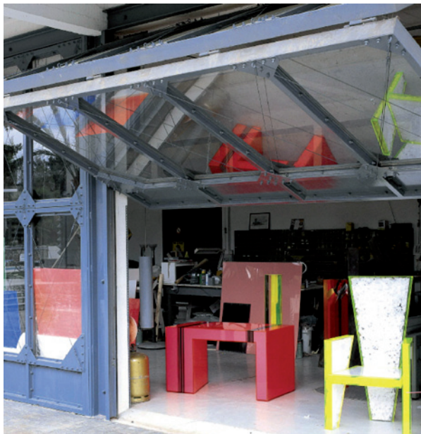
Overmaat en industrieel karakter in de plint
