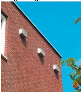
Gierzwaluwneststeen (houtbeton), gierzwaluw houdt nestlocatie schoon van uitwerpselen
