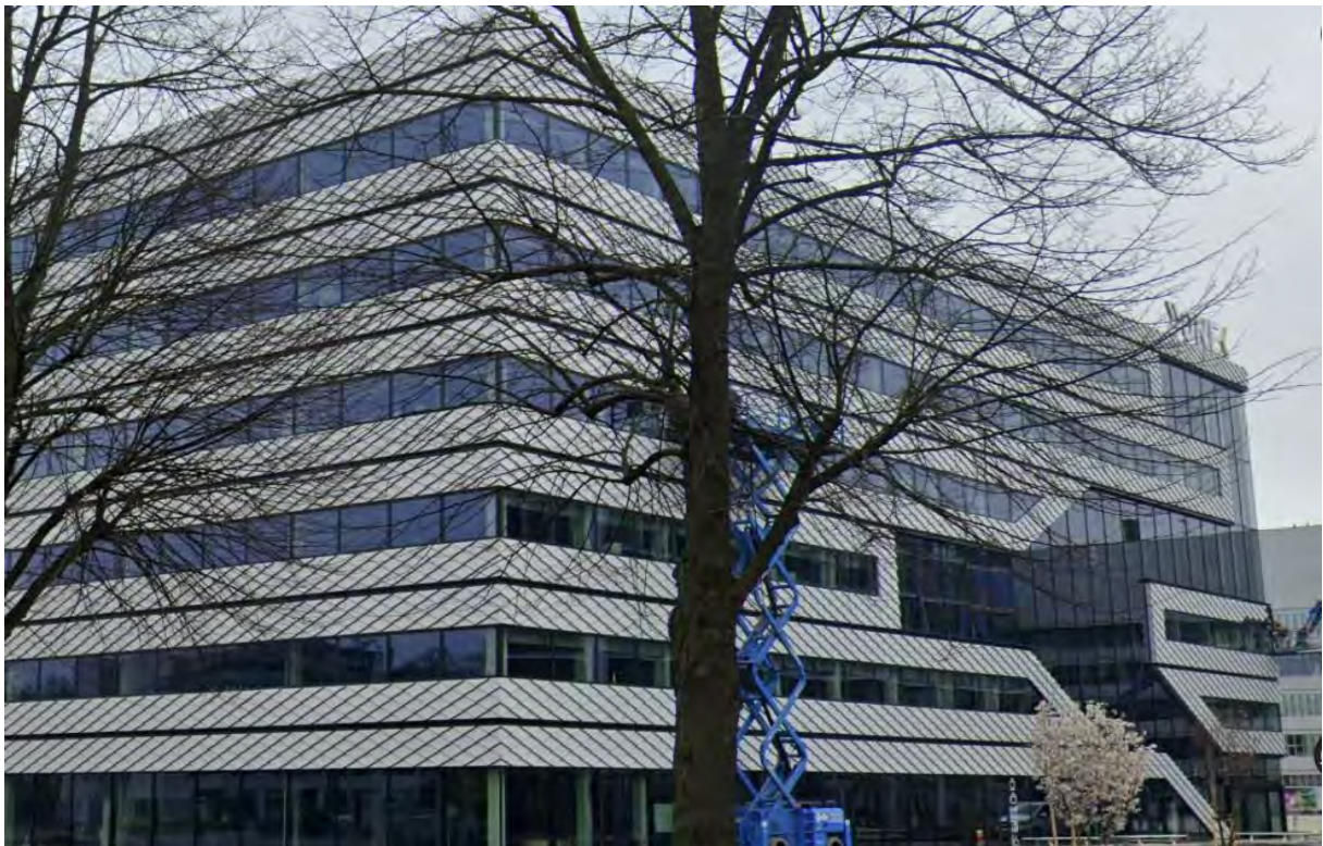
Figuur 2: Gebouw aan noordzijde van het plangebied
