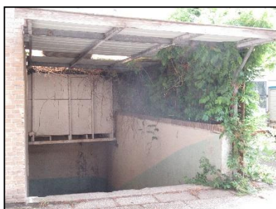
Figuur 19. Keldertoegang gebouw 3.
