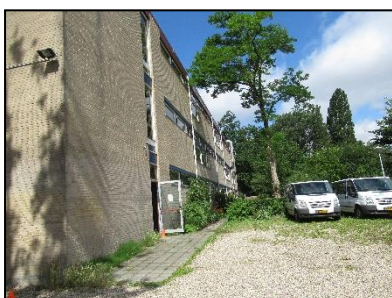
Figuur 6. Gebouw 2, zicht vanaf het parkeerterrein naar het noorden.
