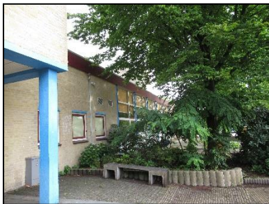
Figuur 3. Gebouw 1, zicht naar het oosten.
