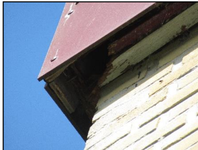
Figuur 24. Ruimte achter timmerwerk.
