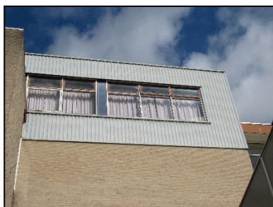
Figuur 10. Gebouw 3, zicht naar het noorden.
