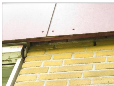
Figuur 12. Gebouw 4, ruimtes achter het boeibord en open stootvoegen.
