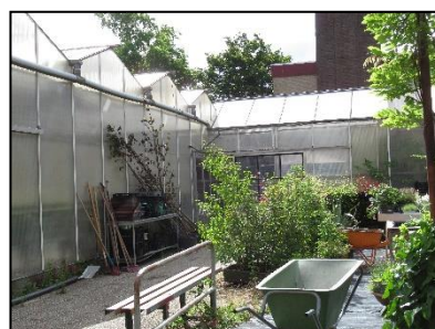
Figuur 17. Gebouw 5, kas aanbouw met aanliggende binnentuin..
