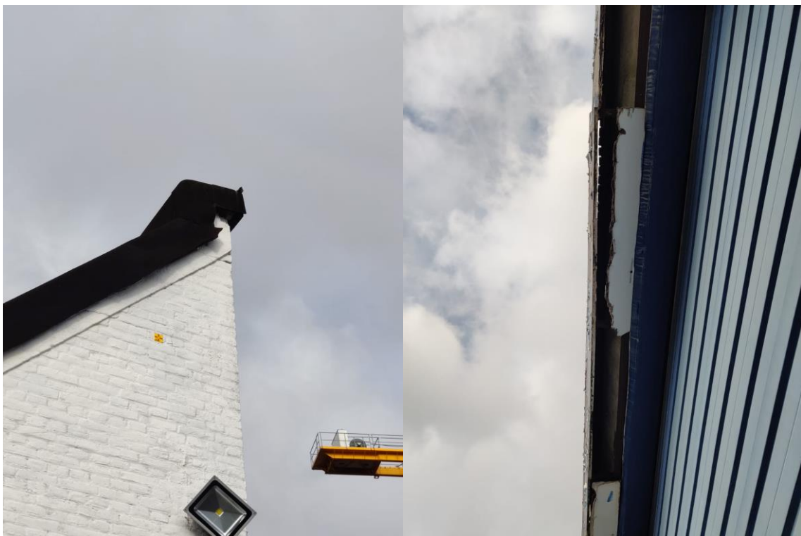
Afbeelding 4.1 Locaties waar vleermuizen in het gebouw en in de spouwmuur van het gebouw kunnen kruipen
