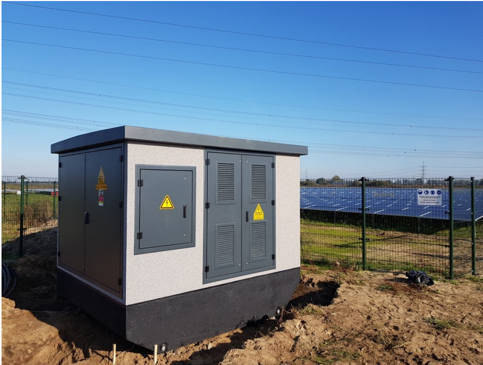
Voorbeeld compact transformatorstation 2000 kVA
