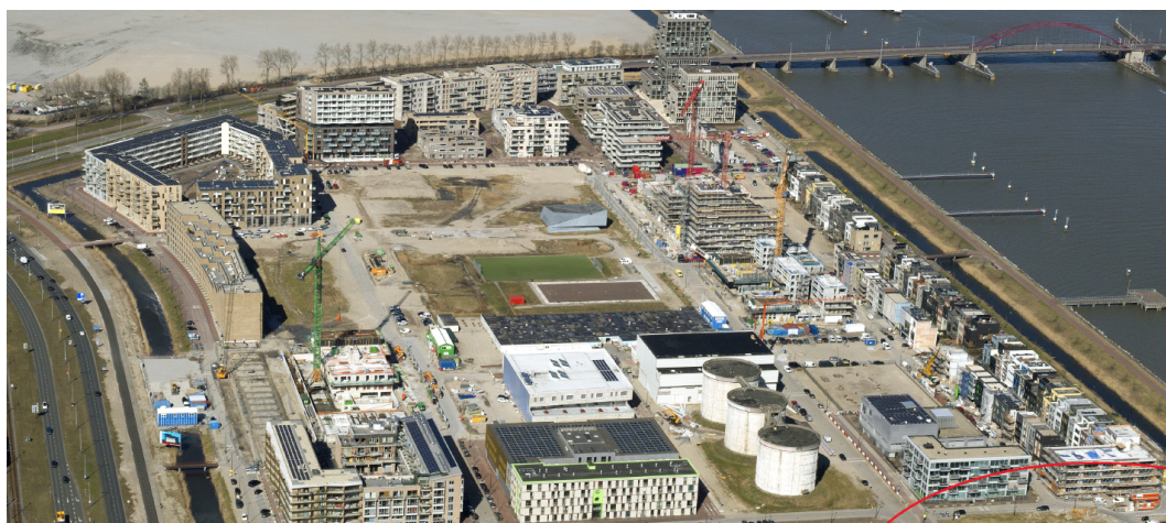
Een luchtfoto met de bestaande situatie. Blok 26 in aanbouw.
