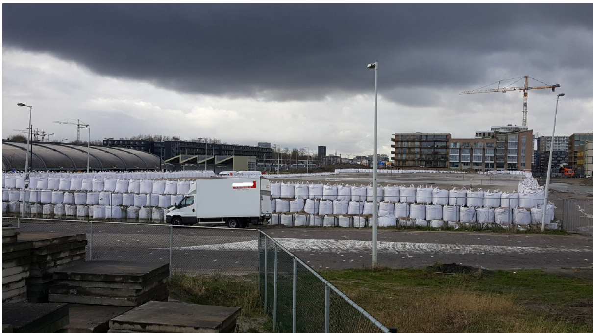
Voorbelasting voor politiebureau en parkeergebouw. Foto: B. Verhoeven / Ecoresult B.V.
