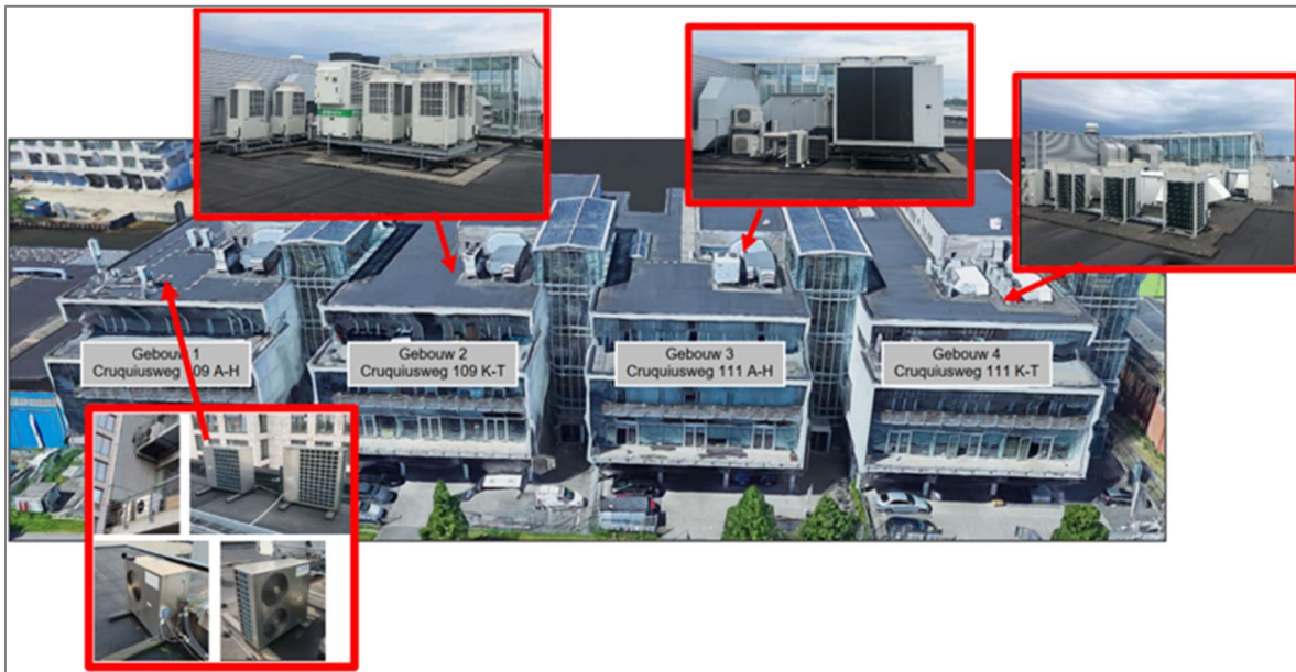
Fig. 3.2: Vogelvlucht van het bedrijfsverzamelgebouw, gezien vanuit het oosten (bron Google Maps 3D view)
