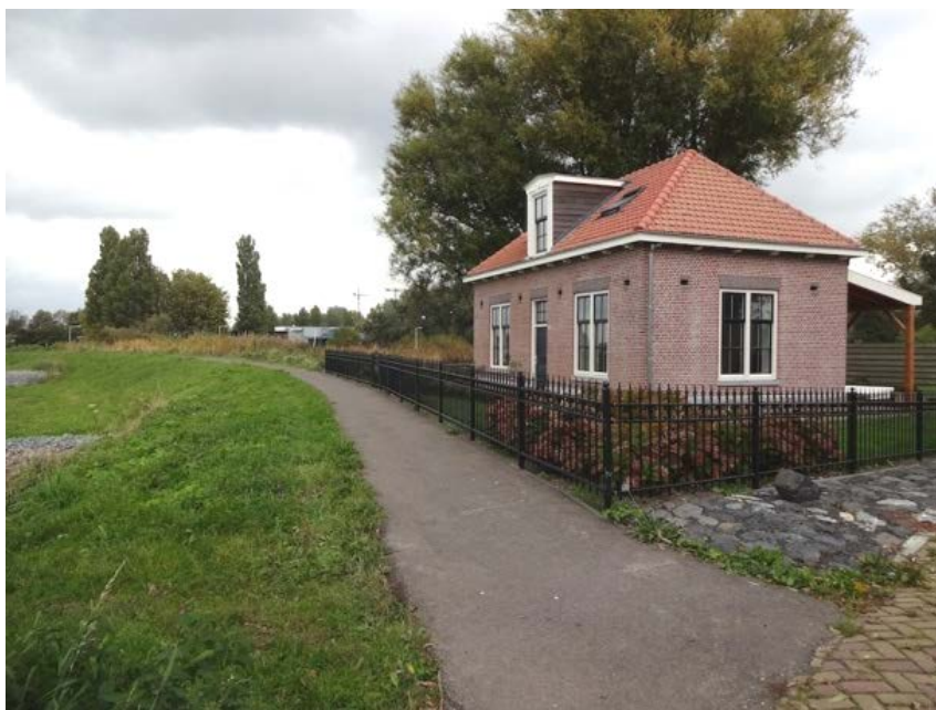
De wachterswoning, Zuider IJdijk 24, in 2016.
