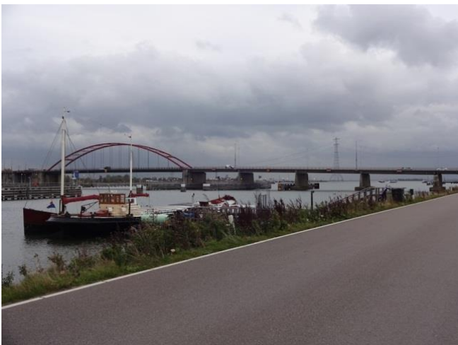
Schellingwoudebrug met aanlanding op het eiland
