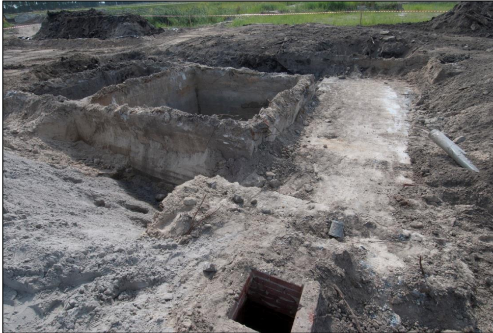
9 De duikerconstructie op het Zeeburgereiland (ZIJD)
