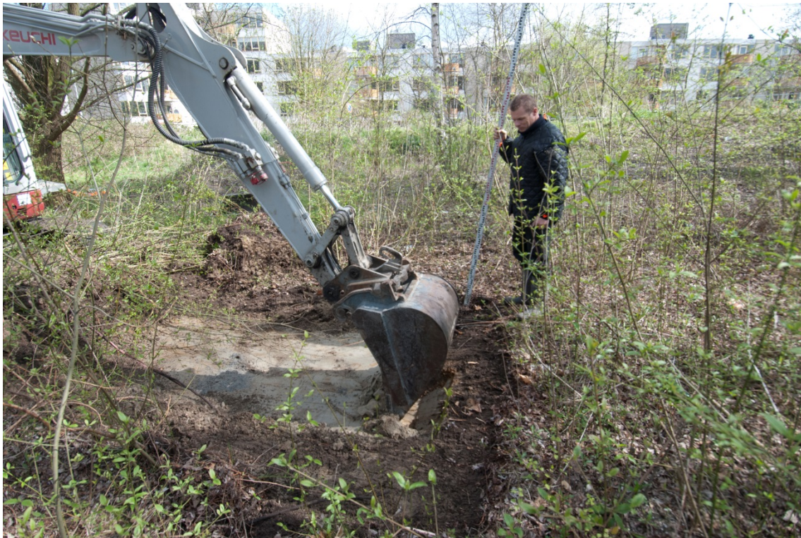
10 In het zuidelijk deel van blok B werd in overleg met de coördinator Kwaliteit en Beheer Bomen van Stadsdeel Oost één locatie zonder hoge bomen uitgekozen voor de aanleg van proefput VI
