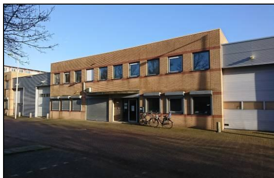
Foto 8: Bedrijfspan met plat dak en stootvoegen
