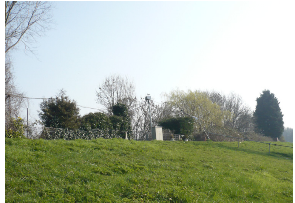
Foto Diemerzeedijk, afscherming van tuintjes met hekken en beplanting
