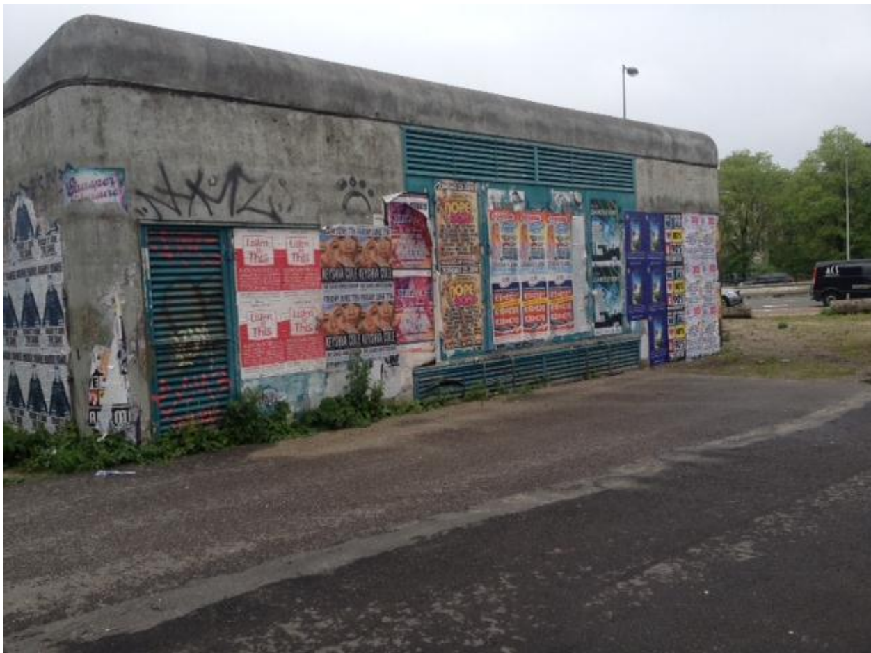
Fig. 4 Het oude gemaalgebouw met ventilatieroosters
