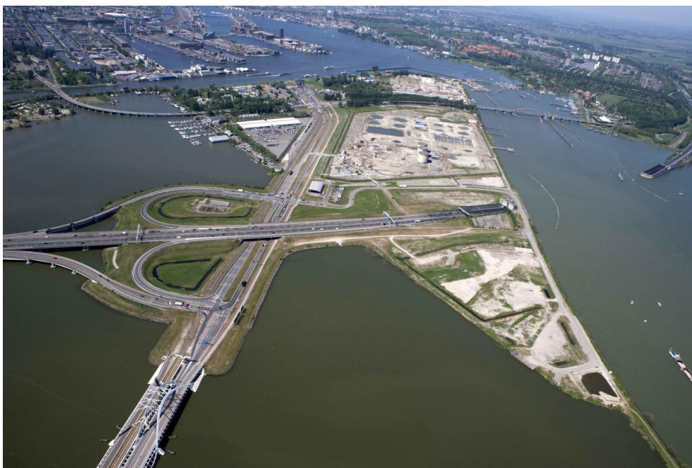
het gehele Zeeburgereiland, gezien vanuit het oosten
